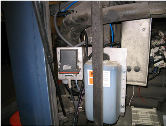
Doseringsanlæg for additiv (plast beholder)
